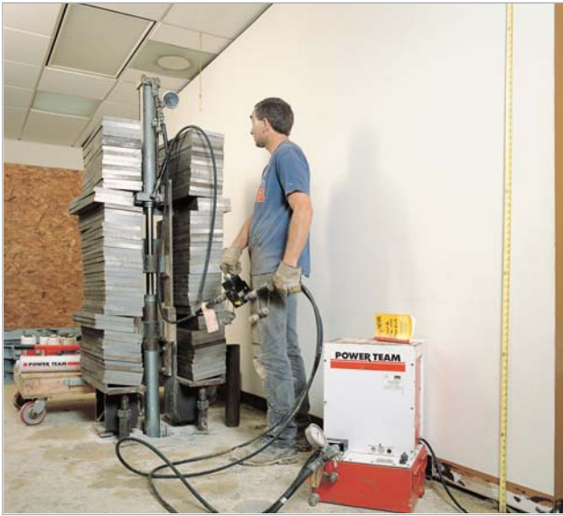
PQ603泵及C256C油缸用于驱动垂直支承构件以顶升并稳定建筑的基础。
